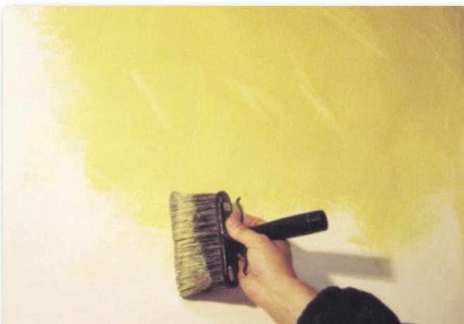
Auf den mit HAGA Mineralputzgrund vorgestrichenen Untergrund wird der LehmColor-Streichputz aufgetragen mit Pinsel, Bürste, Quast.
